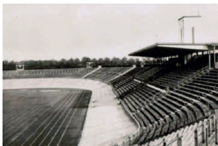
Stangen bij de betonnen rand
