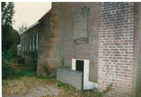
Achteringang kelder onder kerk
