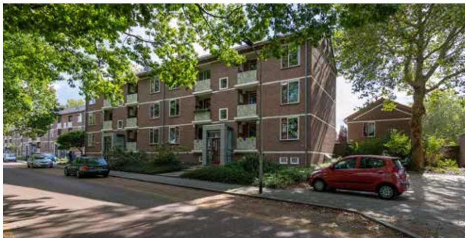
Vernieuwde grotere balkons en uitbouw portiek
